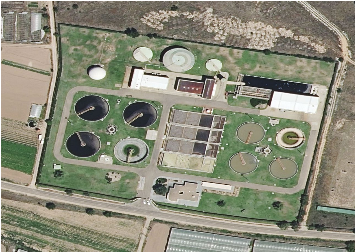
Ilustración 15. Vista aérea de la EDAR.
