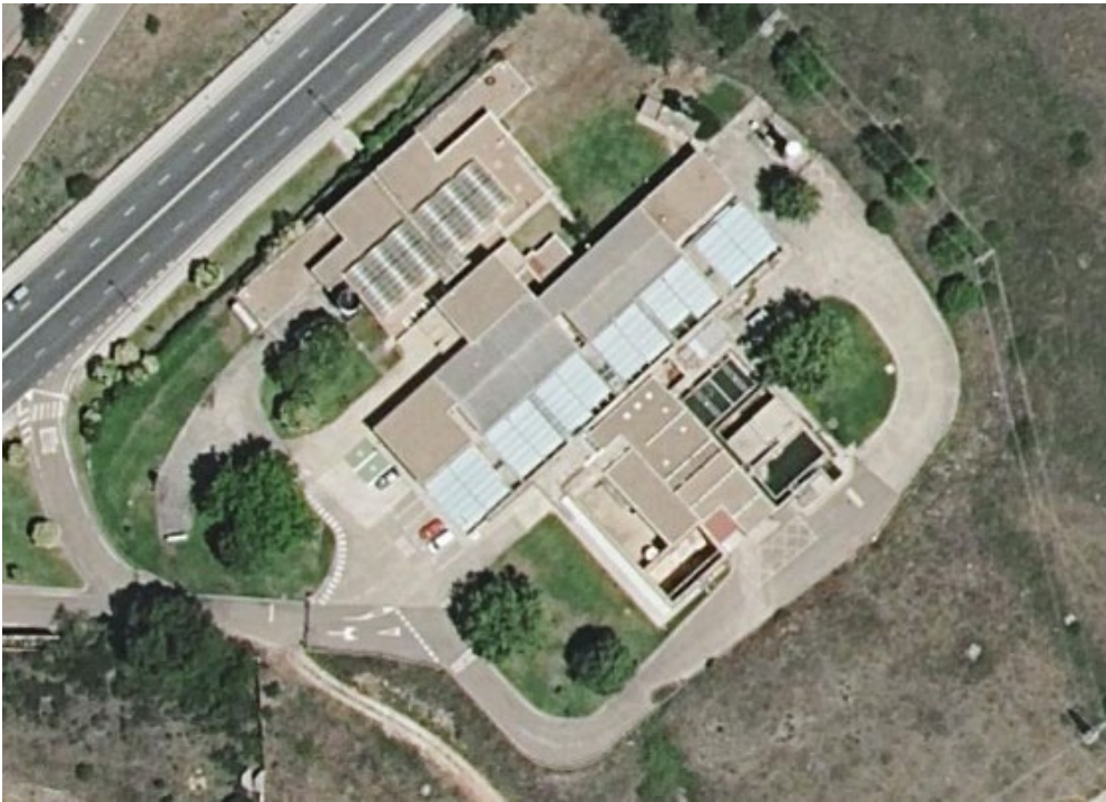
Ilustración 7. Vista aérea de la ETAP Alto de los Curas.
