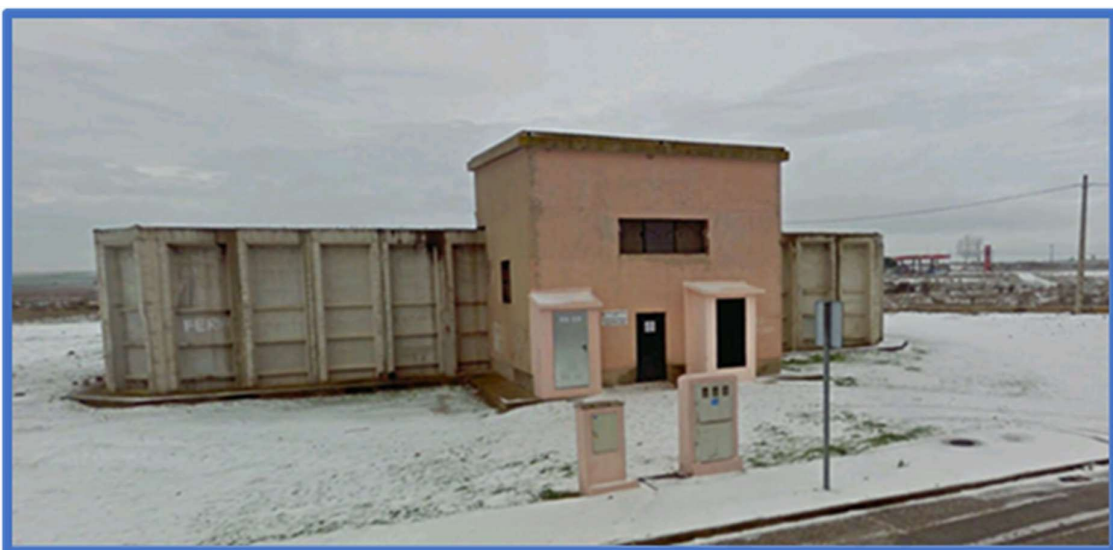
Ilustración 13. Depósito de los Llanos.
