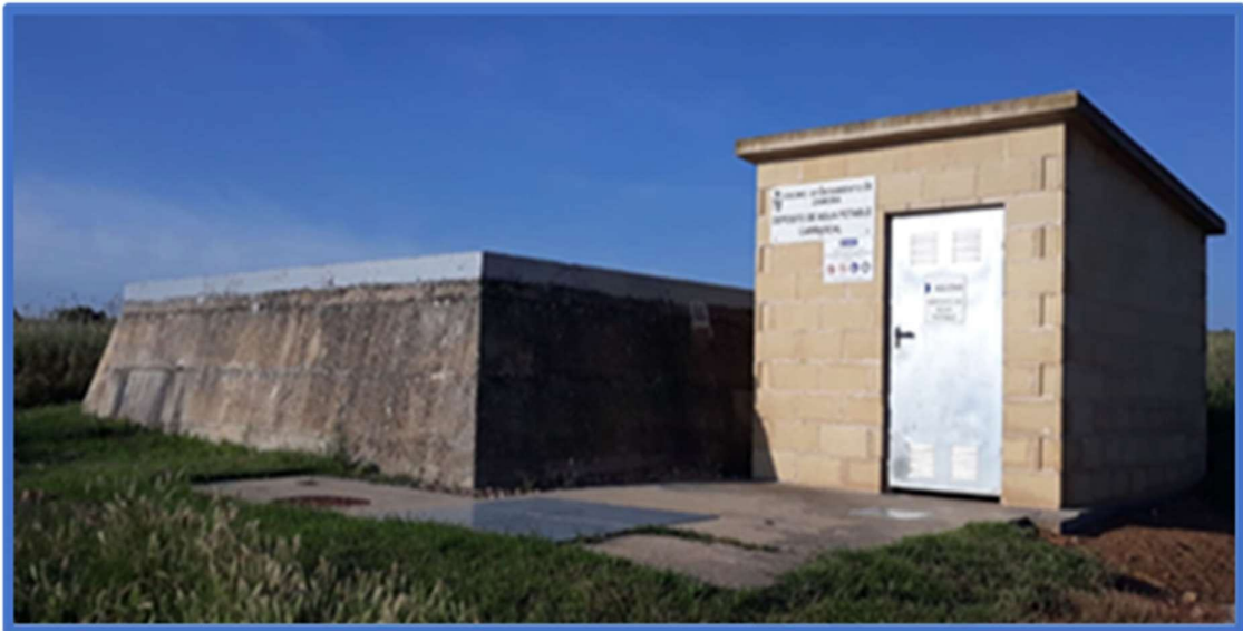
Ilustración 12. Depósito del Carrascal.
